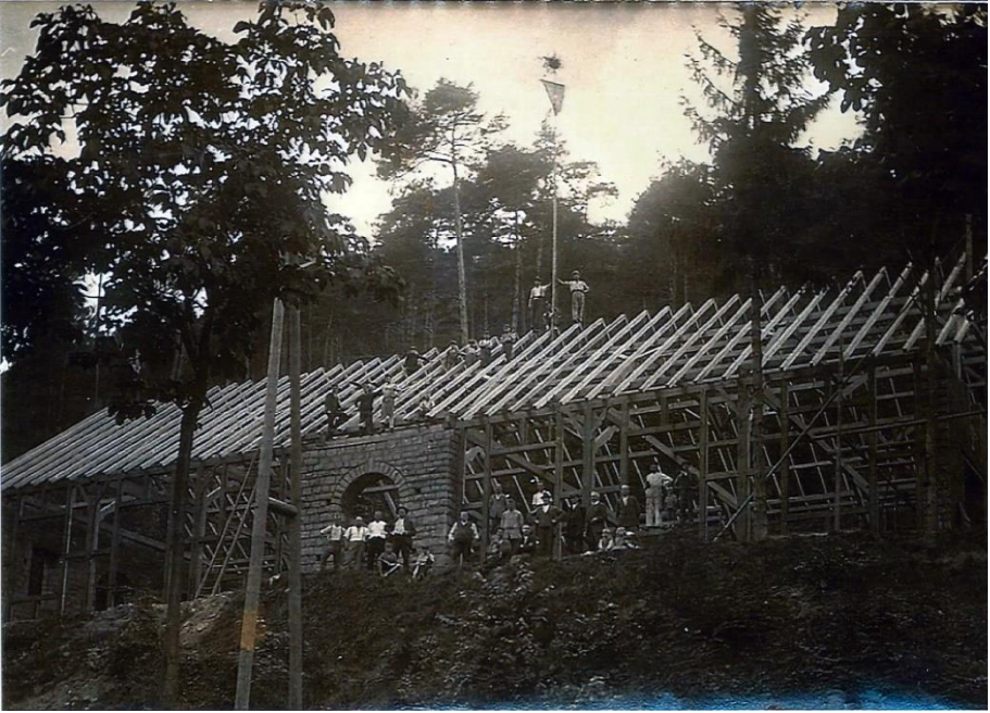
Bau der Turnhalle
