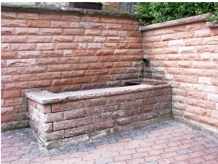
Geiseckbrunnen bevor er vom LKW angefahren wurde
